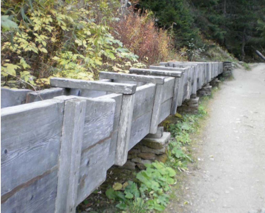
Partie du bisse. Non, il ne coule pas puisqu'il est à sec !
